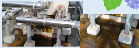
↑修理前:水漏れで機械周りが濡れています。
