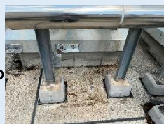
↑修理前:水漏れで機械周りが濡れています。
